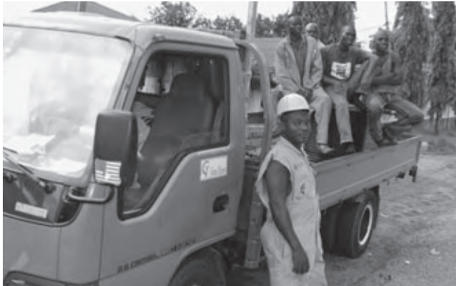
Arbeiten am Telefonnetz in Ghana
