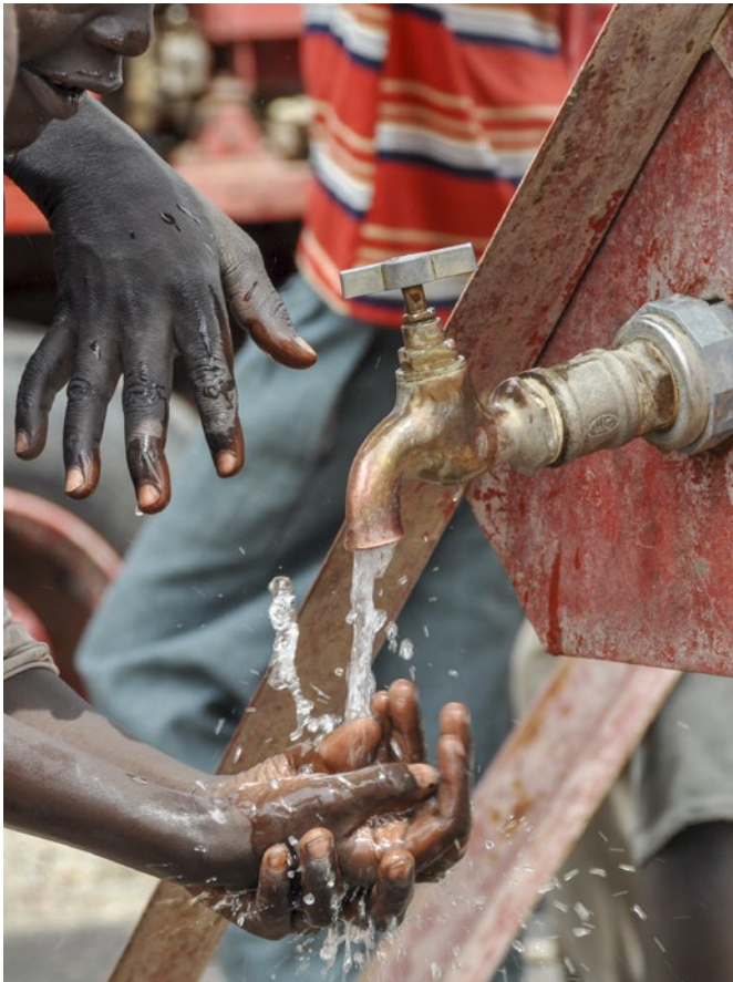
Sauberes Trinkwasser aus dem Tiefbrunnen in der Gemeinde Rier © Hoffnungszeichen e.V.
