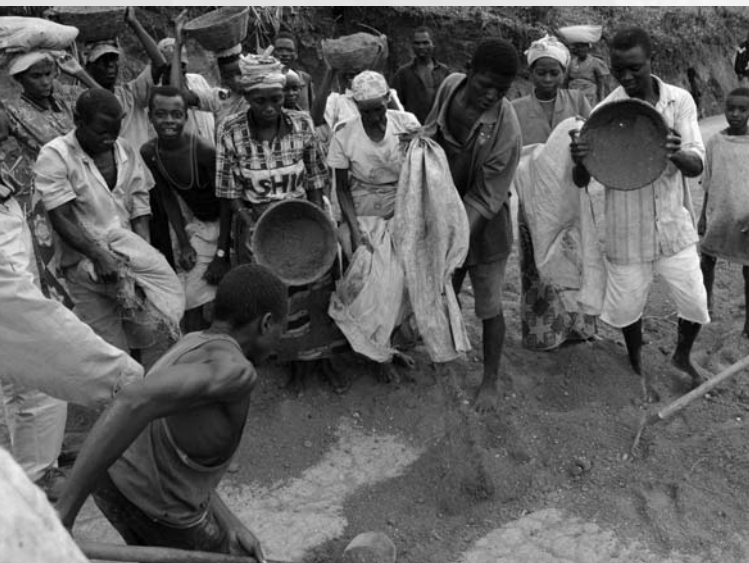
Straßenbauprojekt nahe Kirundo in Burundi
